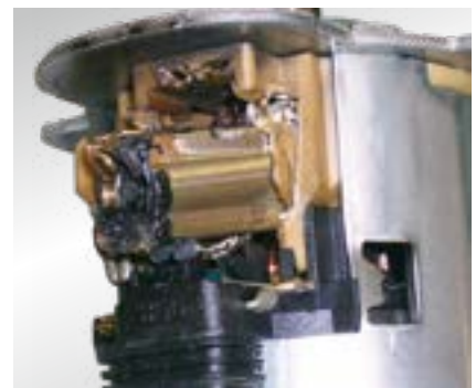
Vue du dommage : traces de fusion sur le moteur électrique ou les contacts électriques
