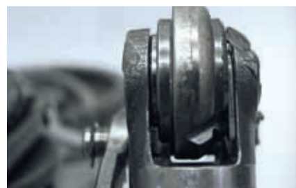
Картина повреждения: сточившийся только с одной стороны приводной ролик
