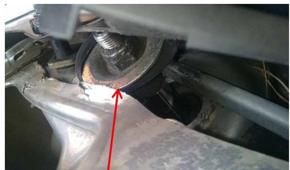
Ensemble butée et bloc de mauvaise qualité
